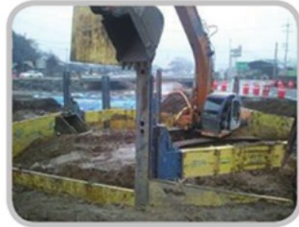
사업명 호남고속철도 5-1 공구 발주처 한국철도시설공단 시공사 금호건설
