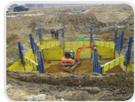
사업명 호남고속철도 4-2 공구 발주처 한국철도시설공단 시공사 쌍용건설
