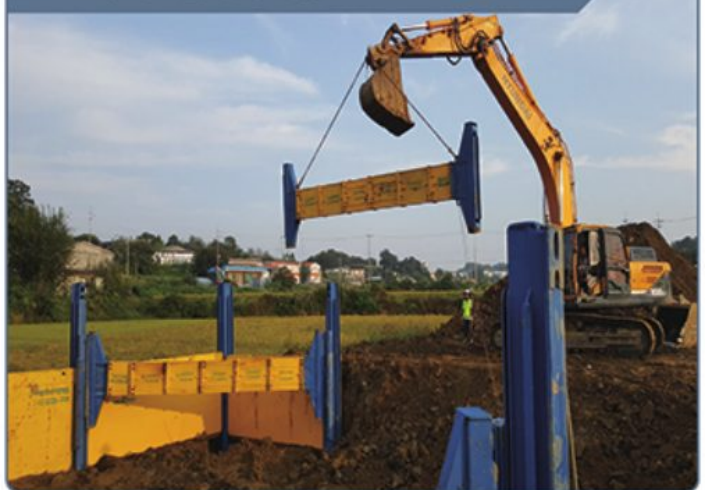
• 교각기초 흙막이 시공
