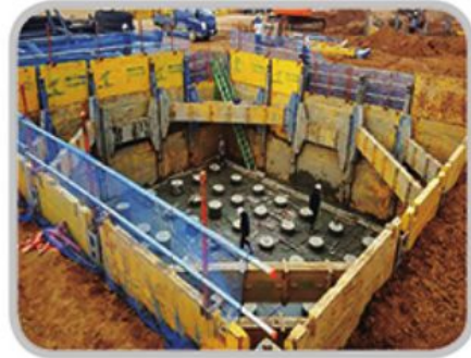
사업명 서해선 복선 전철 제 8공구 발주처 한국철도시설공단 시공사 대림산업
