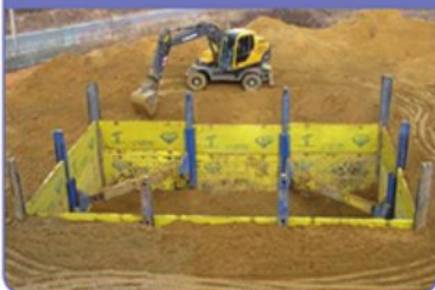
7. 교각기초 흙막이 시공완료
