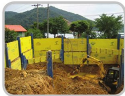
사업명 호남고속철도 5-1공구 발주처 한국철도시설공단 시공사 금호건설
