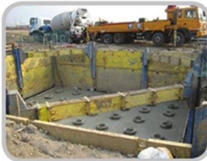
사업명 부산신항만 배후철도 건설공사 발주처 한국철도시설공단 시공사 남광토건
