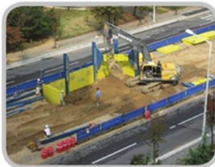
사업명 대구도시철도 3-1공구 건설공사 발주처 한국철도시설공단 시공사 포스코건설
