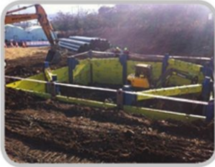
사업명 강남순환고속도로 7-2 공구 발주처 서울특별시 시공사 대림산업
