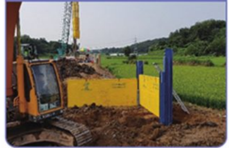
2. 판넬 및 레일 설치
