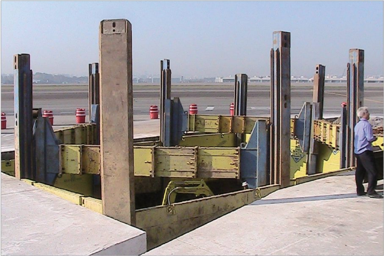
SBH PIT SHORING – 김포공항내 유류탱크설치공사 (한국공항공사)
