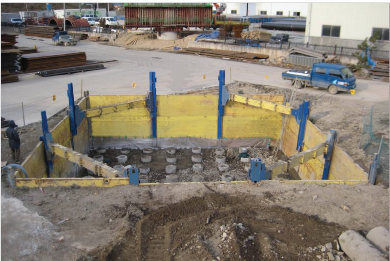
SBH 교각기초 - 부산 신항만 배후철도 (남광토건)
