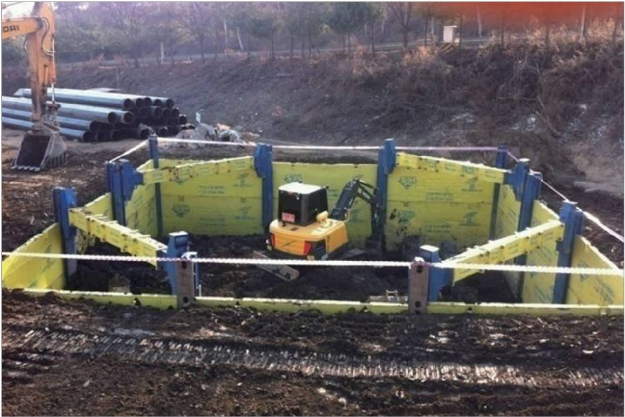
SBH 교각기초 - 강남순환고속도로7-2공구(선암교) (대림산업)
