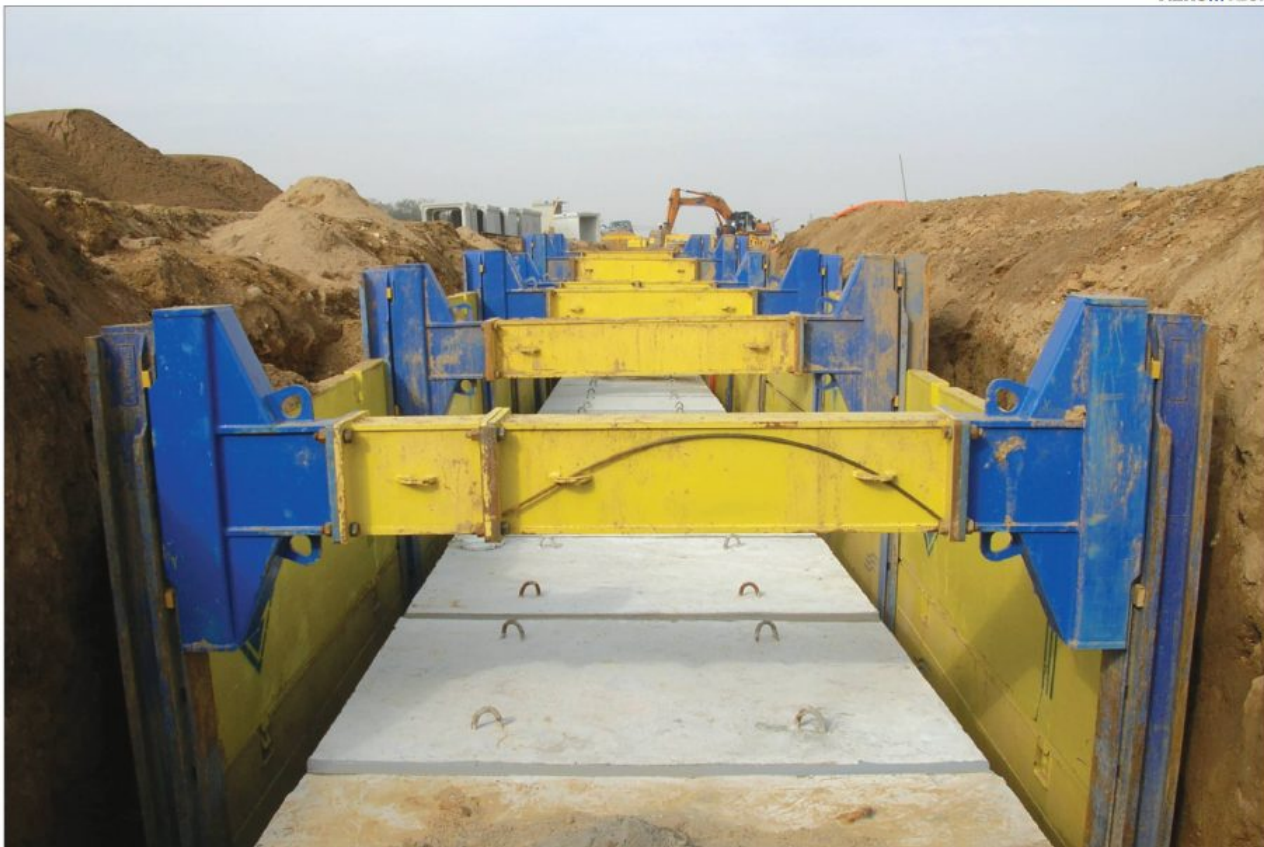
SBH SINGLE SLIDE RAIL - 화성 동탄 택지개발3공구 전력구 공사 (남양건설)
