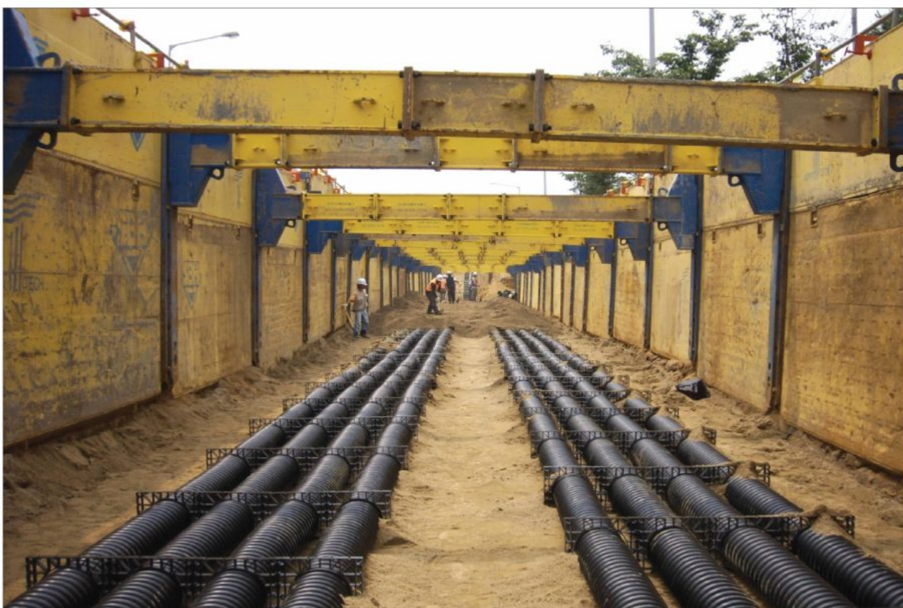
SBH SINGLE SLIDE RAIL - 탕정 U/T 관로공사 (삼성중공업)
