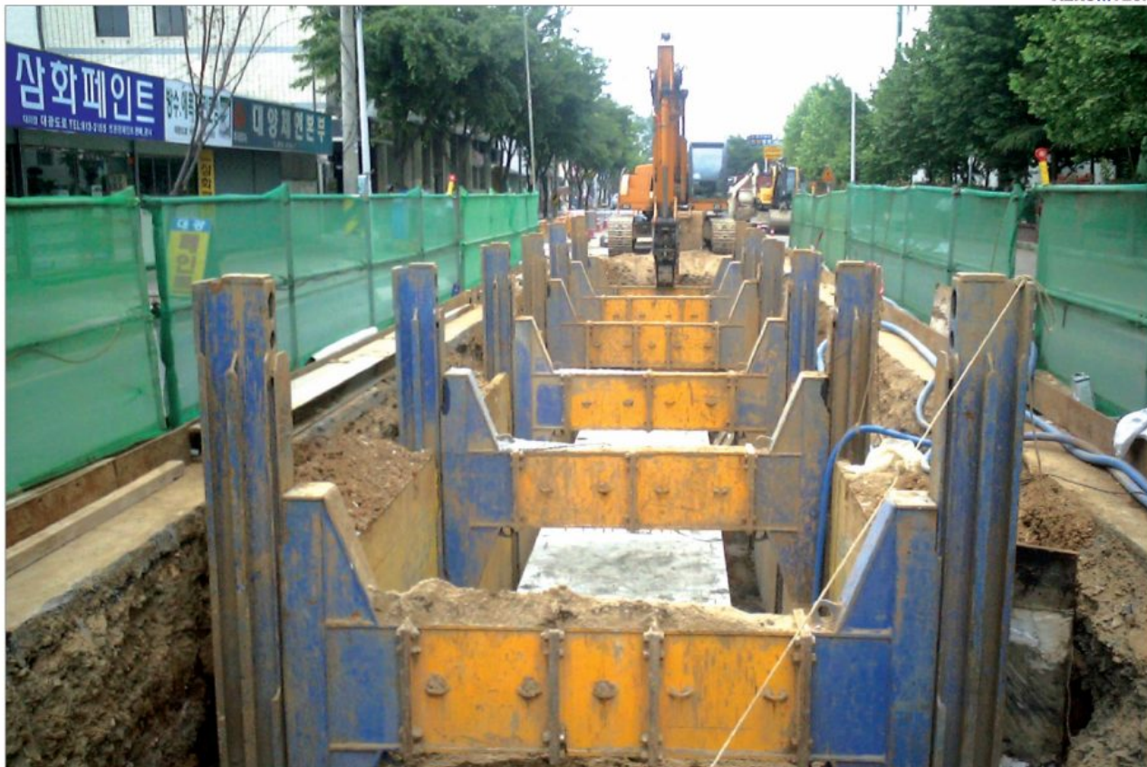
SBH DOUBLE SLIDE RAIL - 경산 하수관거 정비공사 (한진중공업)
