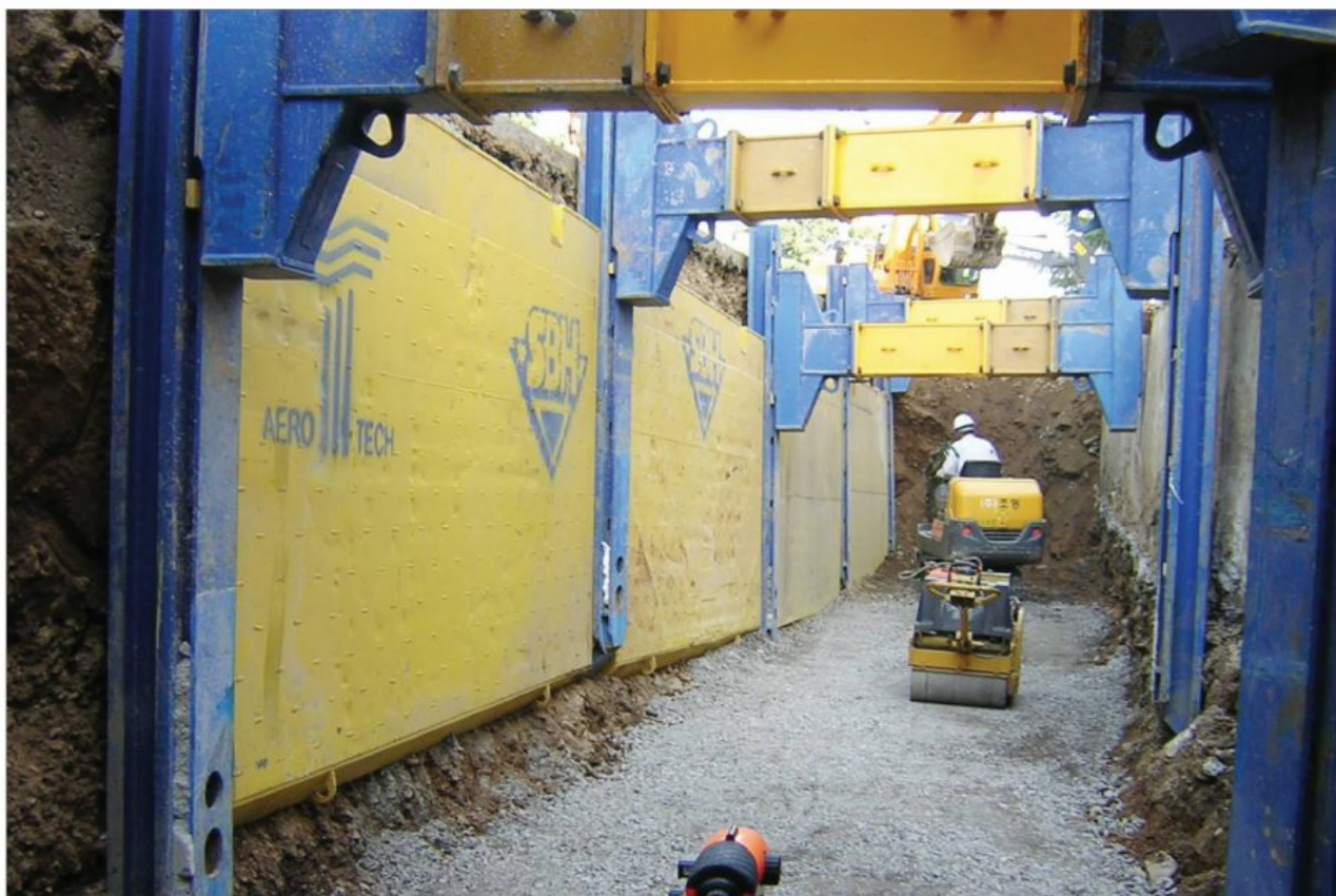
SBH SINGLE SLIDE RAIL - 경산 하수관거 정비공사 (한진중공업)
