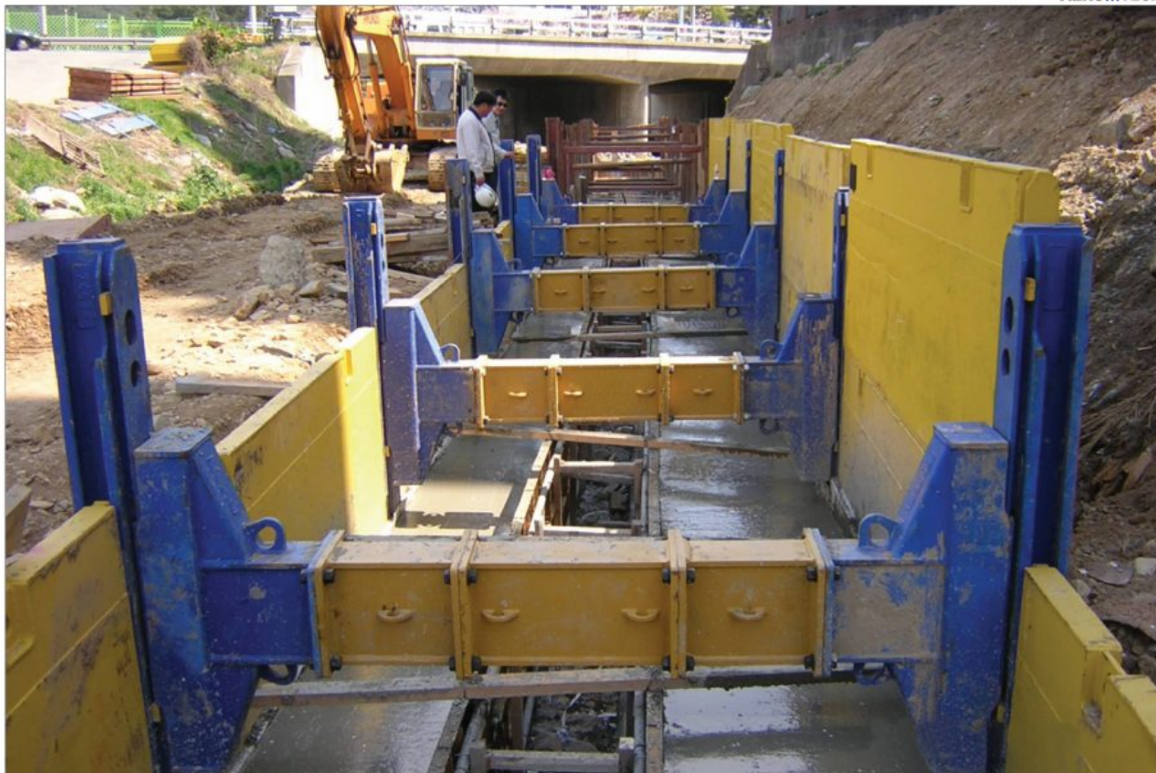
SBH SINGLE SLIDE RAIL - 부산 기장 하수관거 정비공사 (롯데건설)
