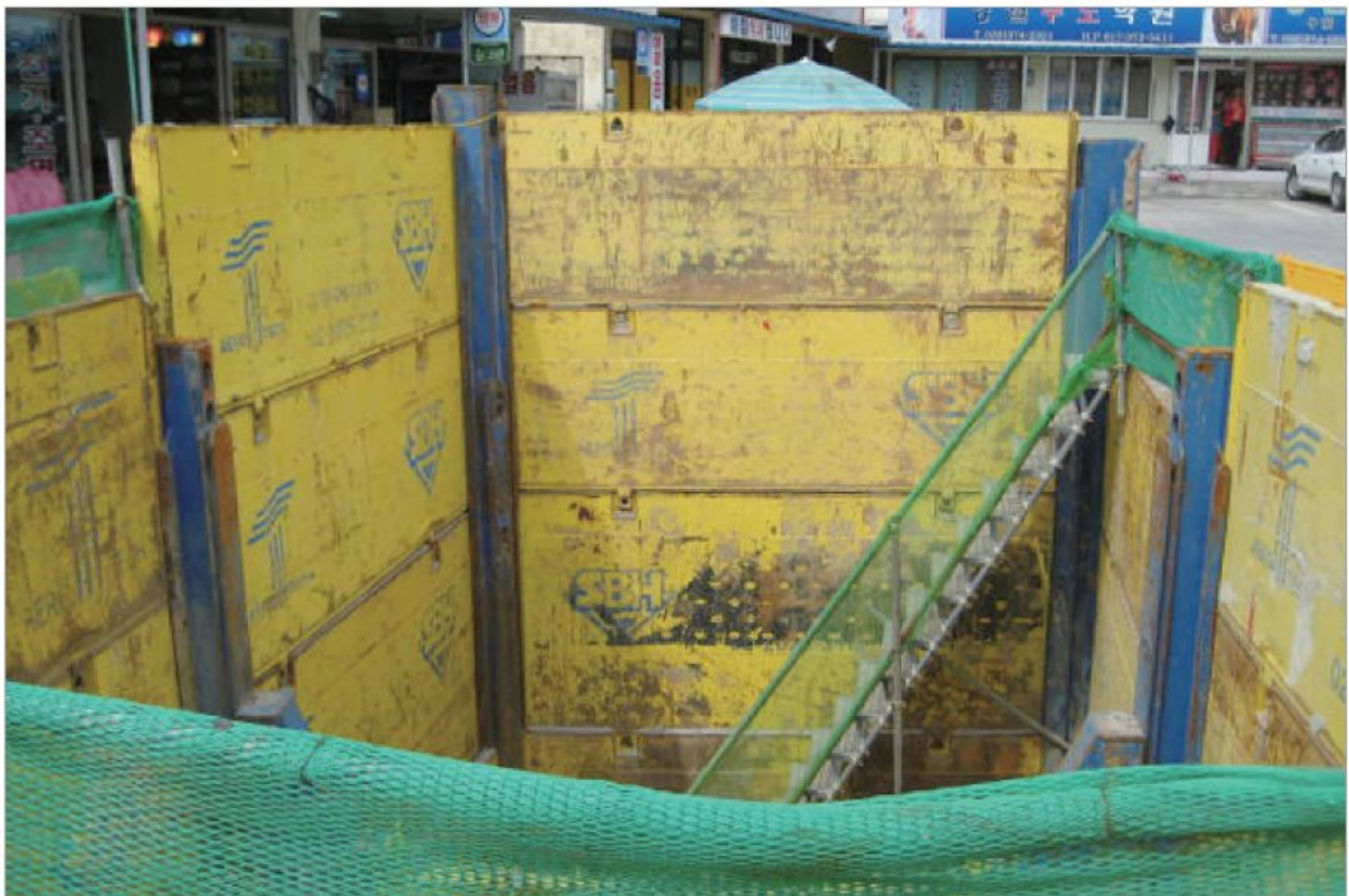
SBH PIT SHORING – 충주댐상류 하수도시설 확충공사 (현대건설)
