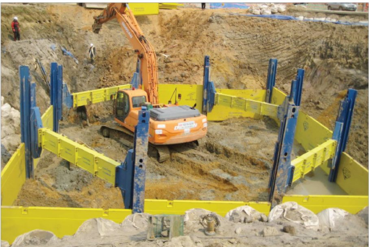
SBH 교각기초 - 호남고속철도 4-2공구 (쌍용건설)
