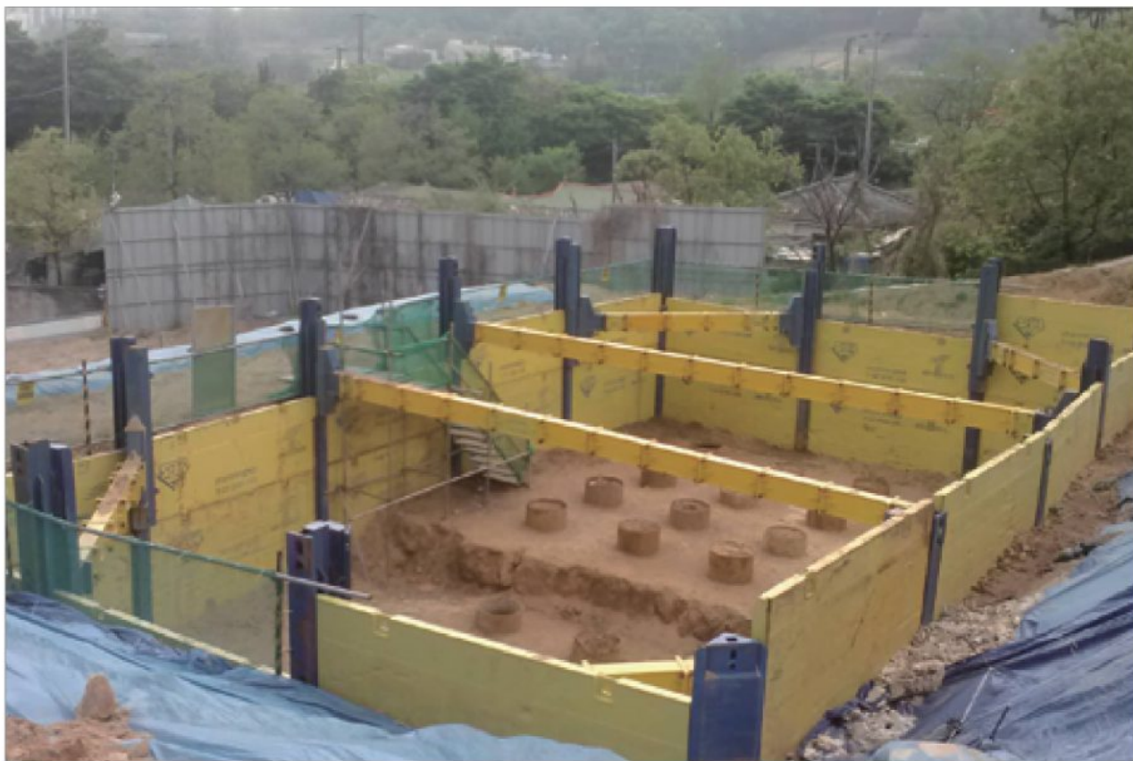
SBH 교각기초 - 경부고속철도 6-3공구(현대건설)
