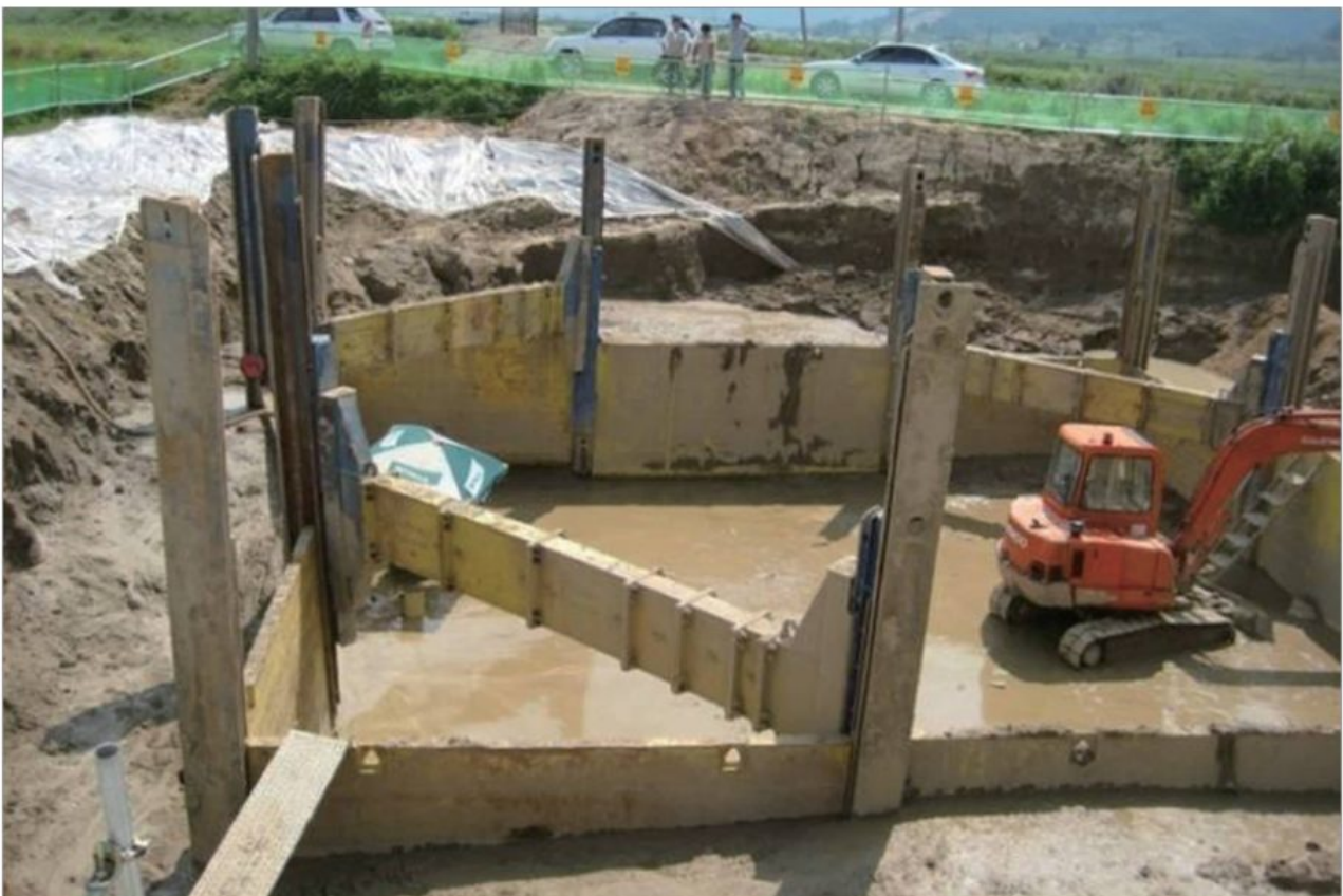
SBH 교각기초 - 호남고속철도 4-4공구(한진중공업)
