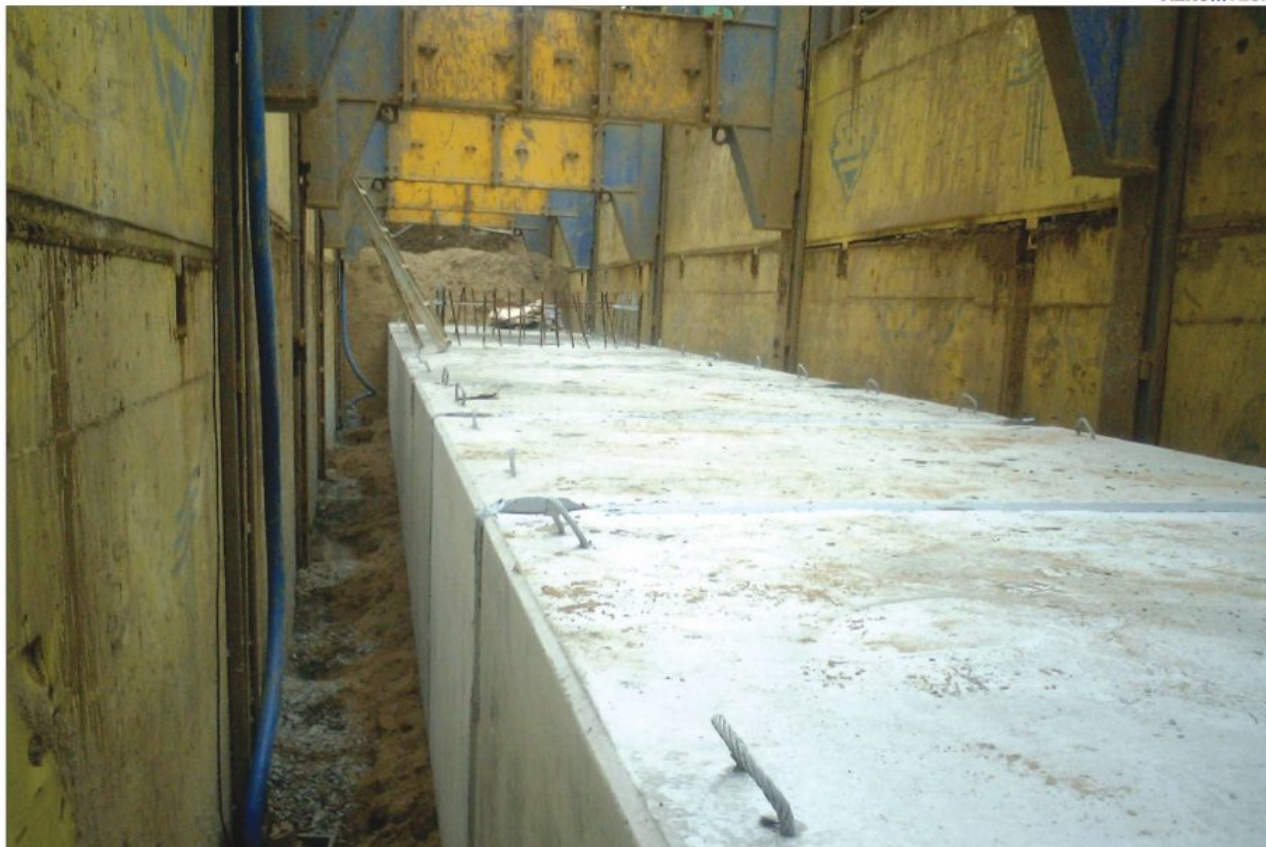
SBH DOUBLE SLIDE RAIL - 서산 예천지구 하수관거 정비공사 (전우토건)
