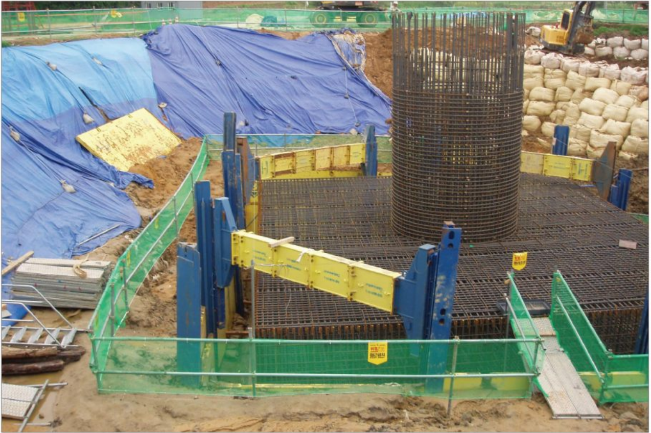
SBH 교각기초 - 고양 삼성택지개발지구 4공구 (현대건설)
