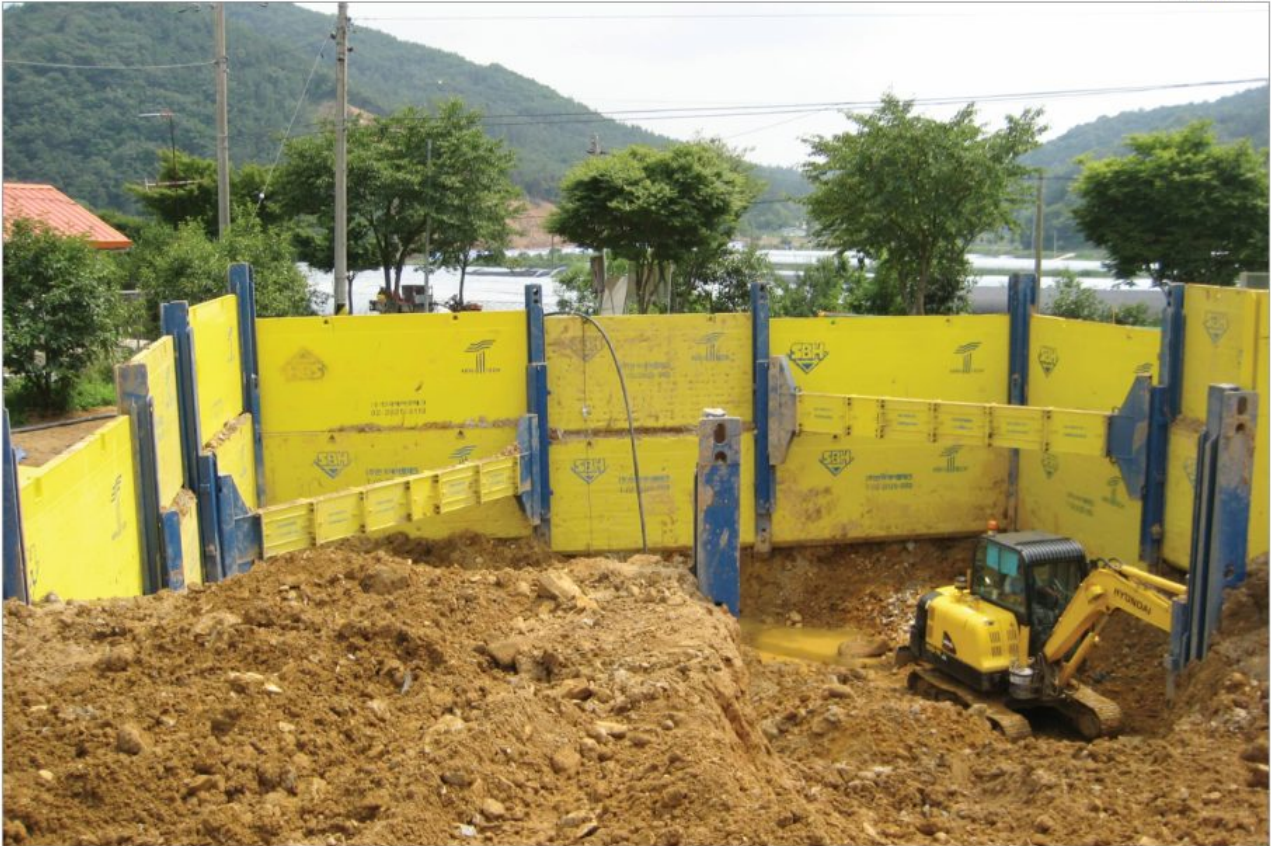
SBH 교각기초 - 호남고속철도 5-1공구 (도양기업)
