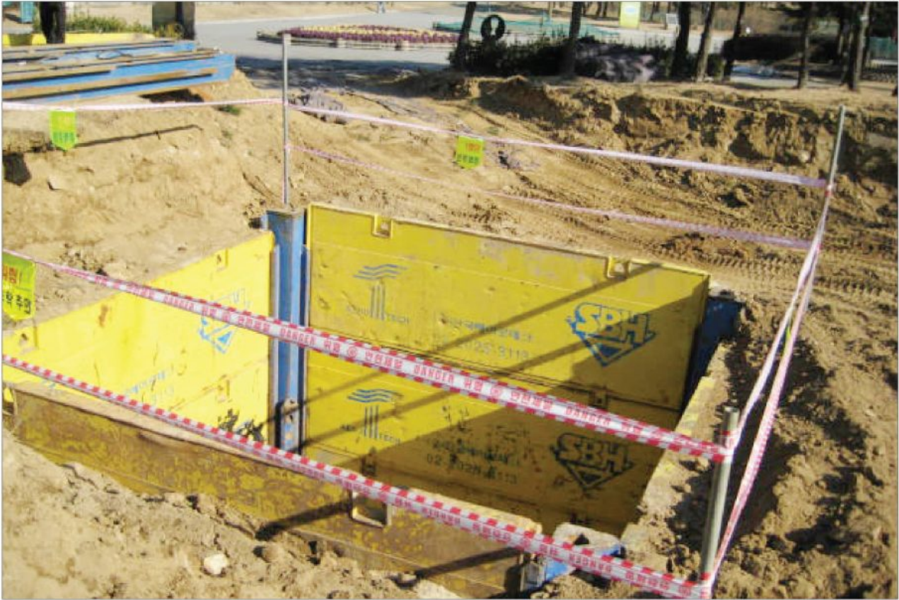
SBH PIT SHORING – 여의도 하수관거 개량공사 (계림산업)
