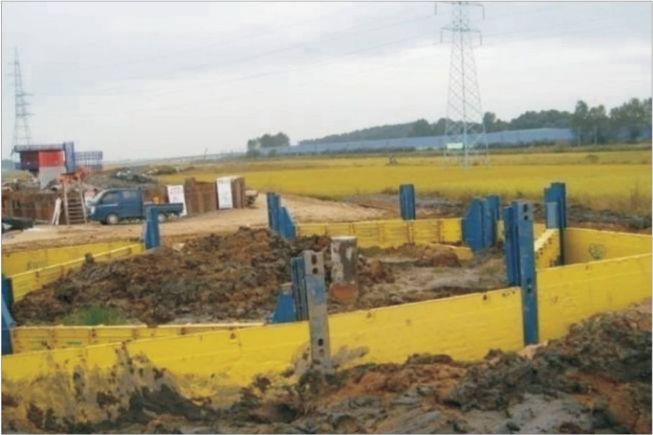
SBH 교각기초 - 호남고속철도 3-4공구(현대산업개발)
