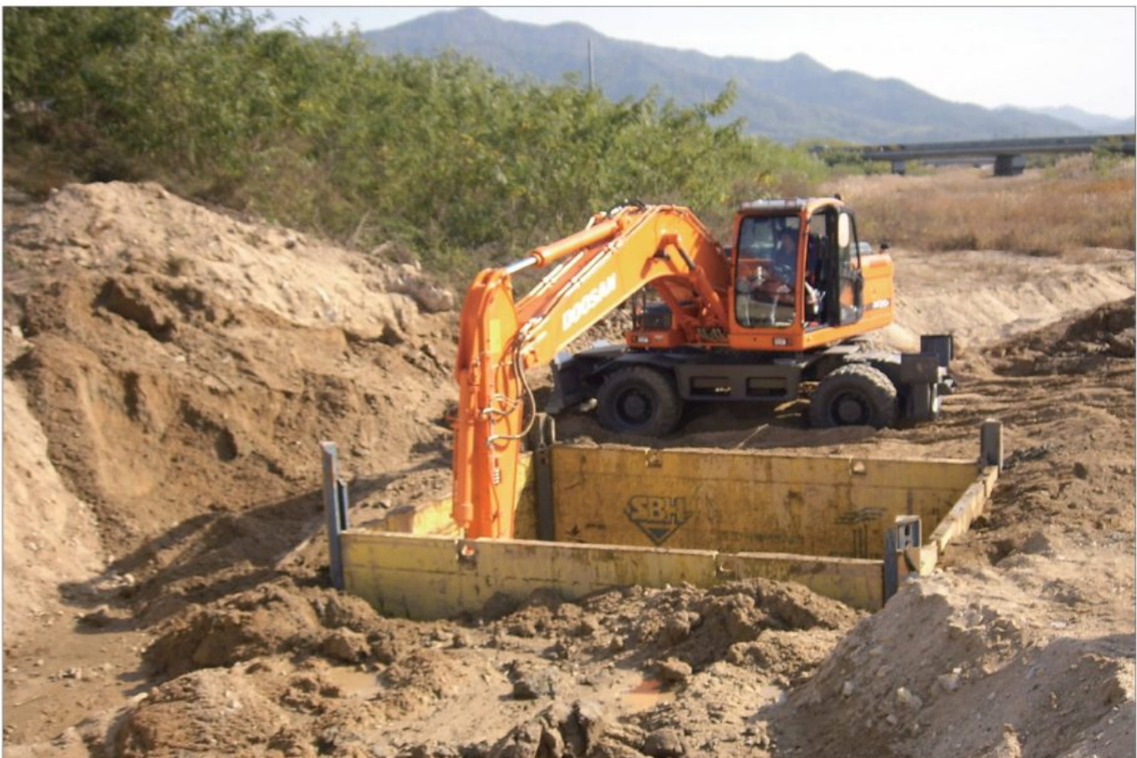
SBH PIT SHORING – 아포하수종말처리장 (한진중공업)
