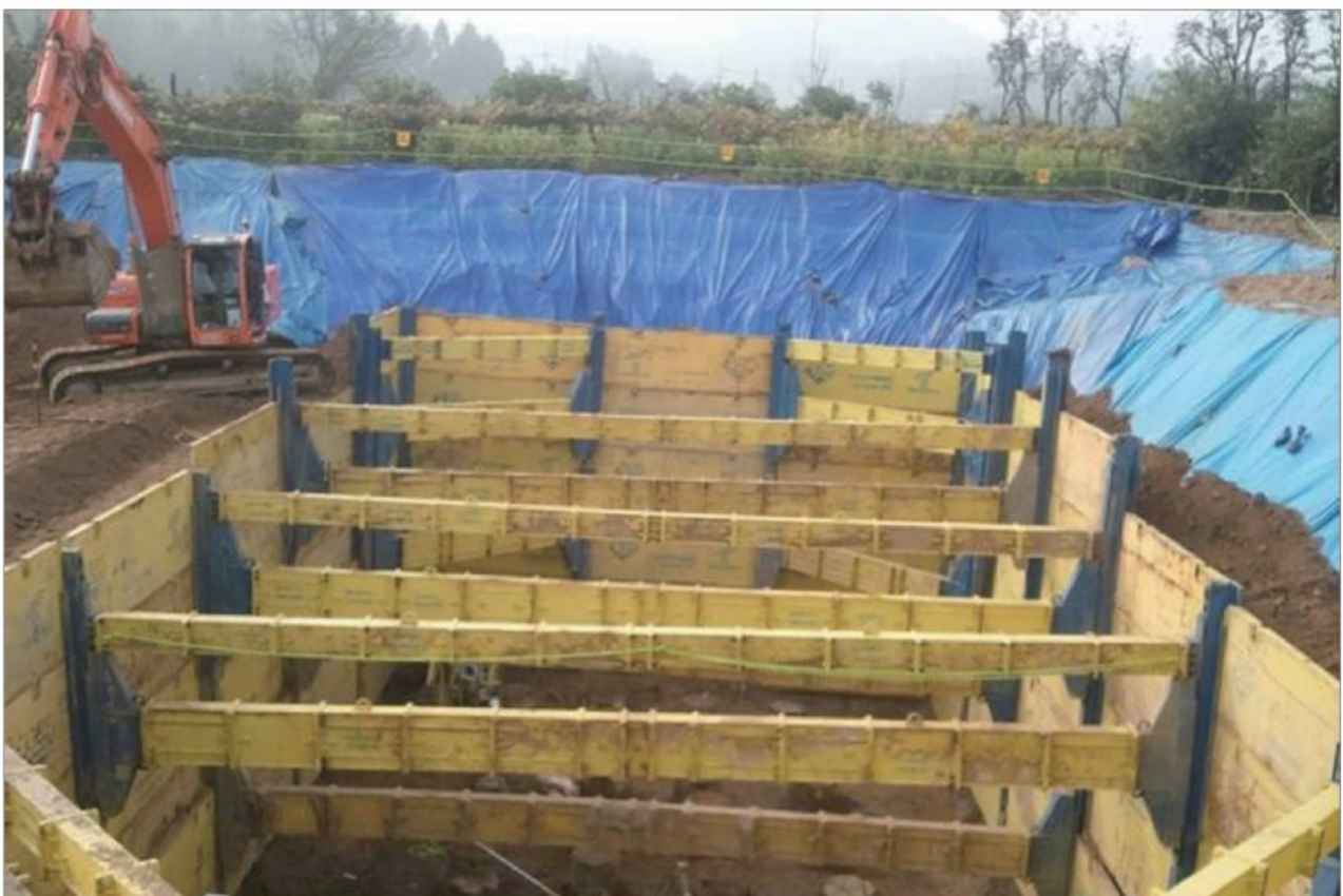
SBH 교각기초 - 경부고속철도6-3공구 현대건설)
