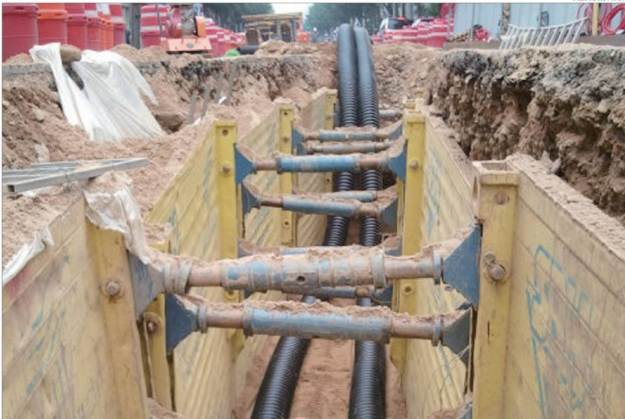
SBH LIGHT BOX - 임진하수종말처리시설 (한진중공업)
