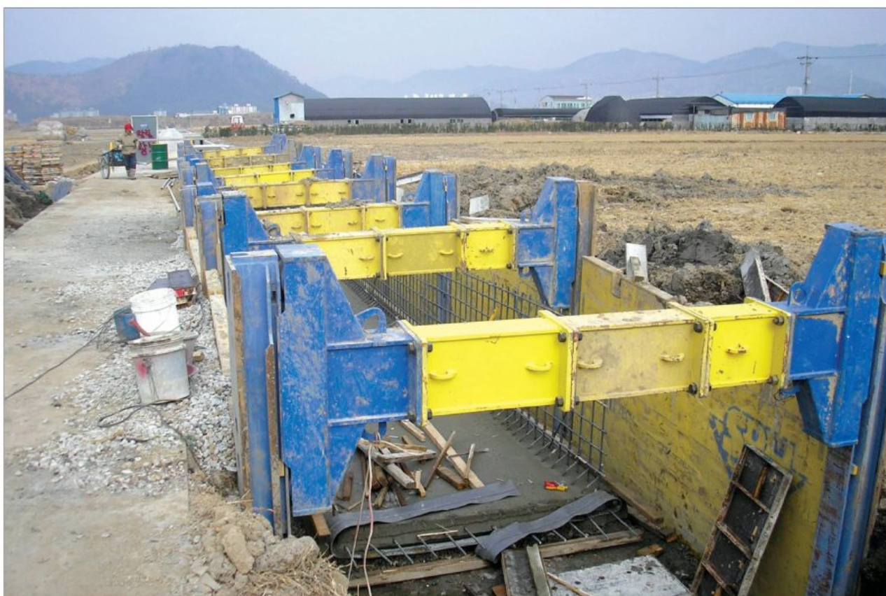
SBH SINGLE SLIDE RAIL - 김해 하수관거 정비공사 (대우건설)
