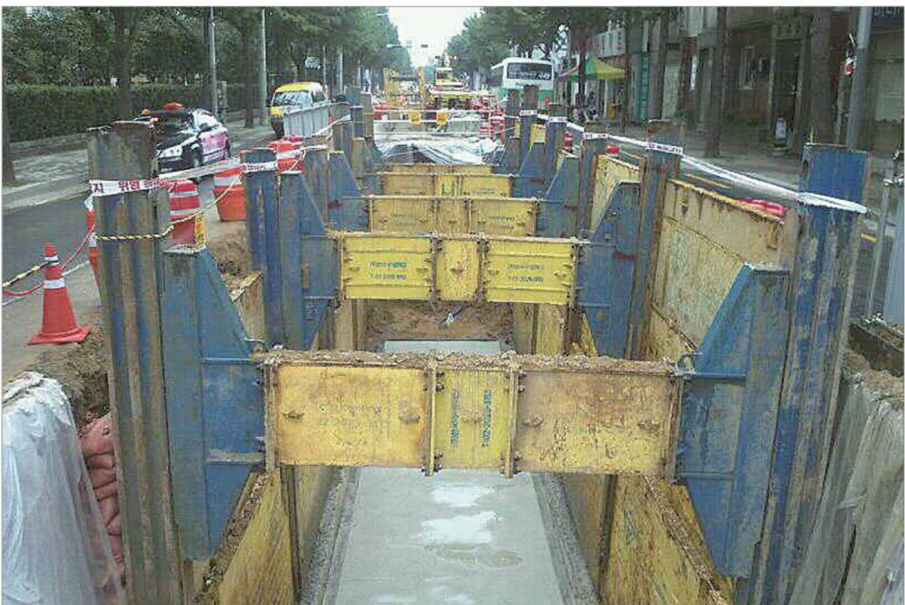
SBH DOUBLE SLIDE RAIL - 대구봉덕지구전력구공사 (롯데건설)
