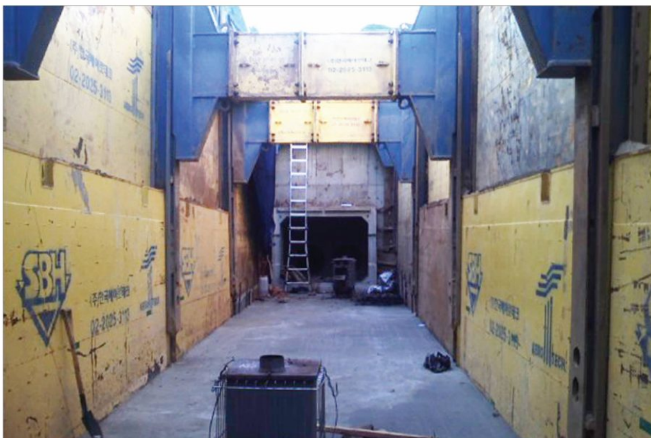
SBH DOUBLE SLIDE RAIL - 여의도 하수관거 개량공사(계림산업)
