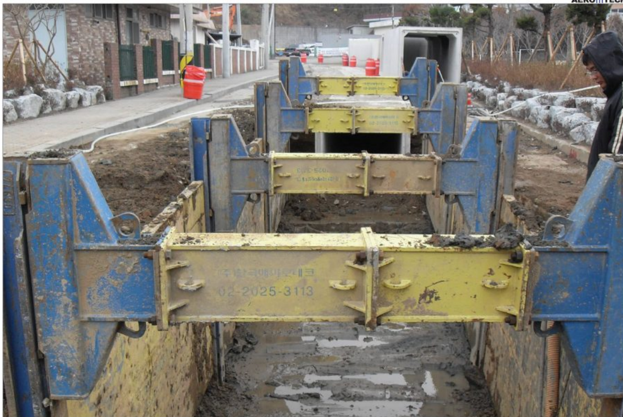
SBH SINGLE SLIDE RAIL - 벌교시가지 침수개선복구공사 (송천종합건설)
