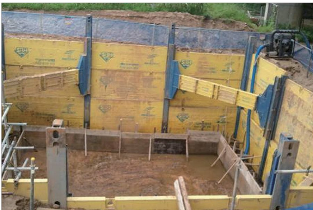
SBH 교각기초 - 대구혁신도시 진입도로 건설공사(2공구)
