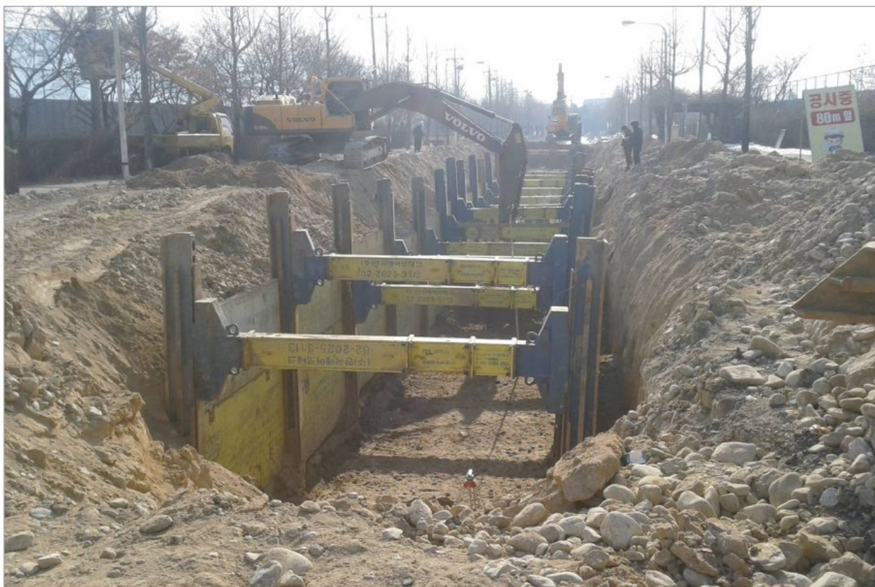
SBH DOUBLE SLIDE RAIL - 원주~문막 반계 산업단지 조성공사 (한라건설)
