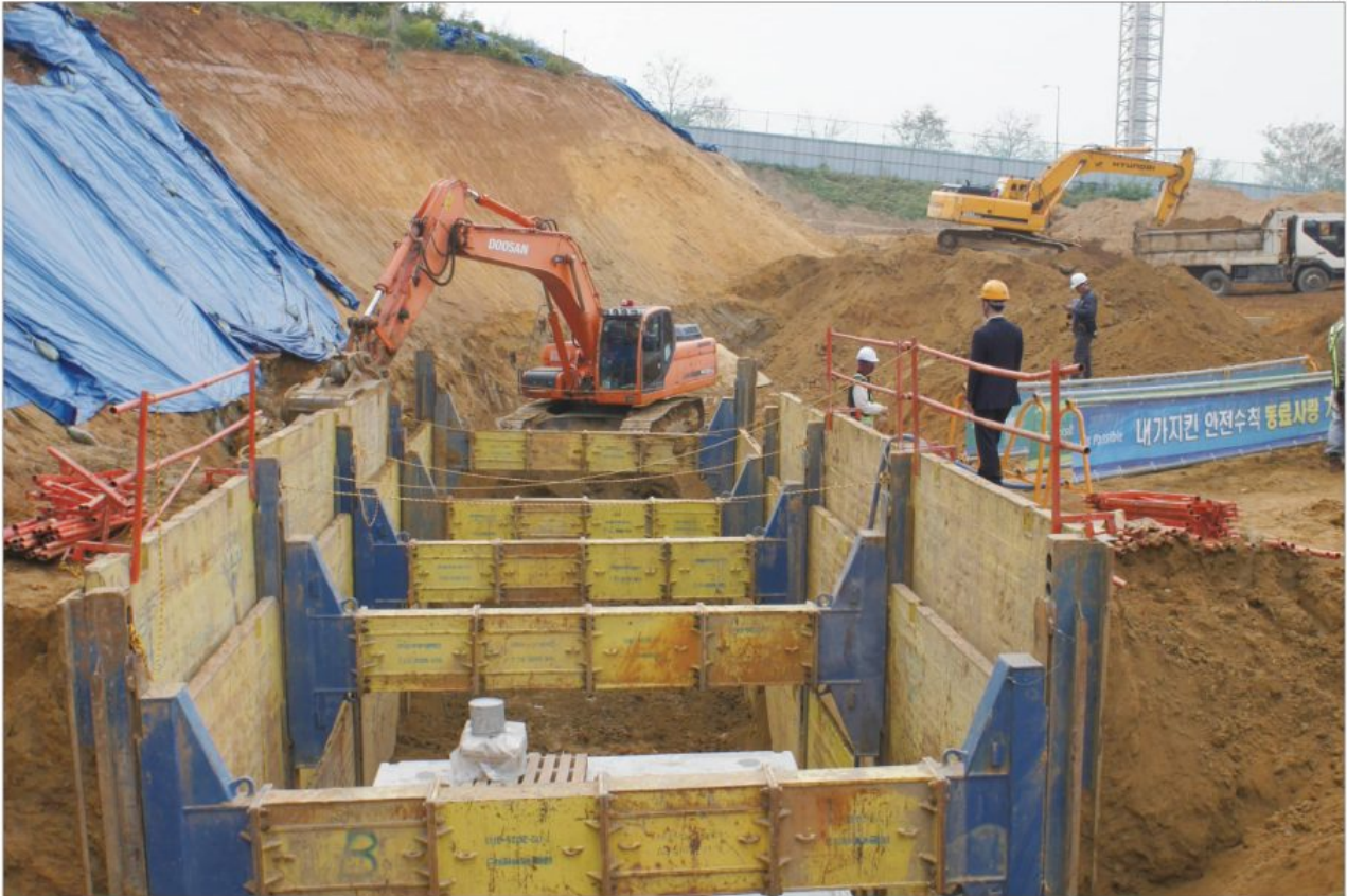
SBH DOUBLE SLIDE RAIL - 수원 ~ 평택BTL (미화산업)
