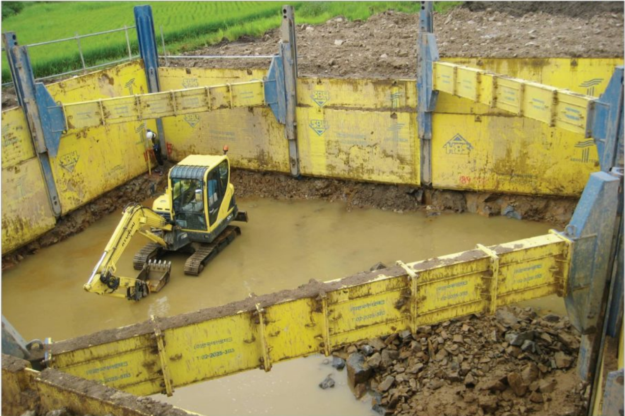
SBH 교각기초 - 호남고속철도 5-1공구 (도양기업)
