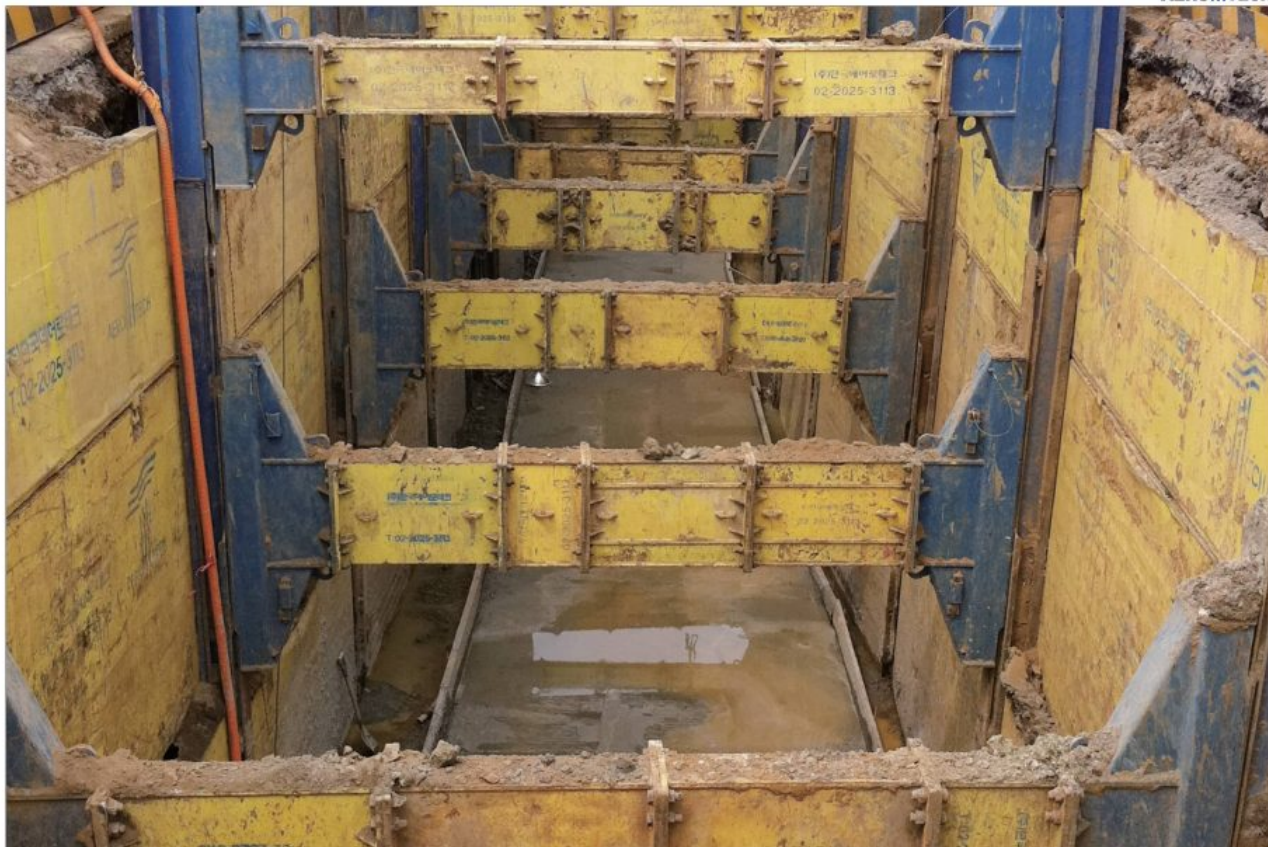
SBH DOUBLE SLIDE RAIL - 오산세교지구 택지개발사업3공구가시설 (한신공영)
