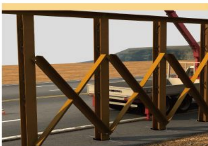
04 띠장, 브레싱 설치
