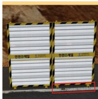
05 2번 SET에 SET ANCHOR 설치
