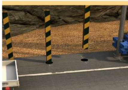
01 천공 및 H-Beam 설치
