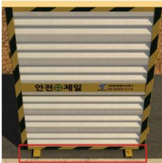
02 SET ANCHOR를 설치
