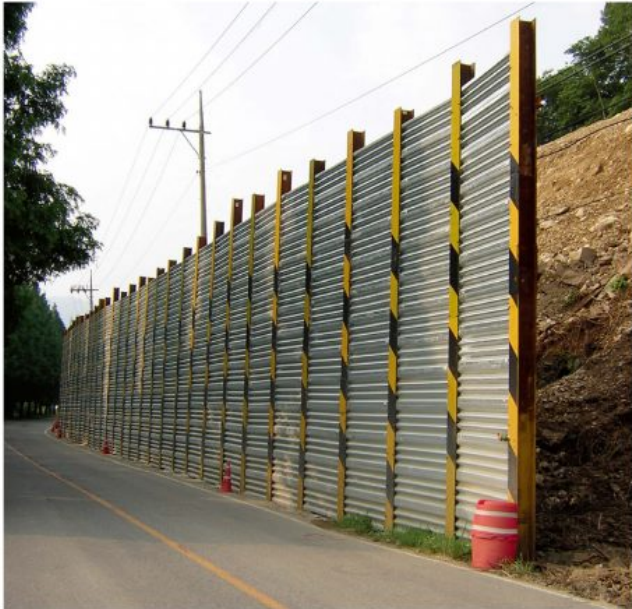
구룡포-대보간 국도 확장 공사 - 울트라건설
