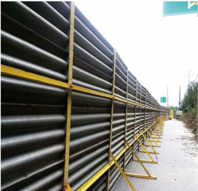
국도38호선 산사태 정비공사
